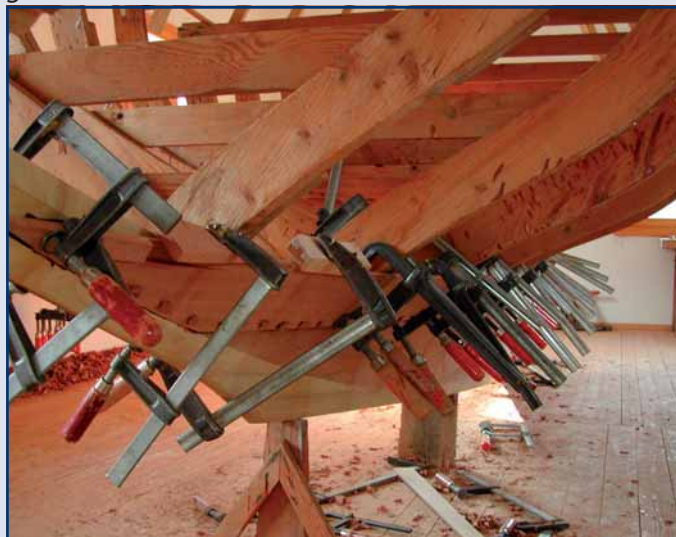
Die zweite Planke wird bereits am stehenden Mallengerüst montiert
