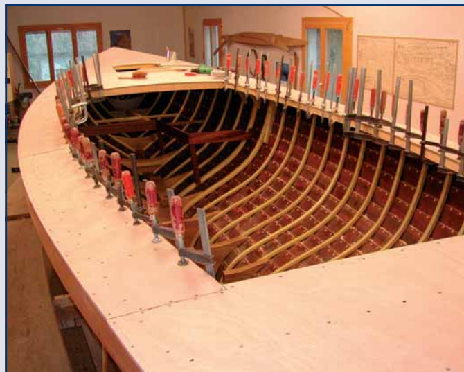
Das Deck wird aufgelegt
