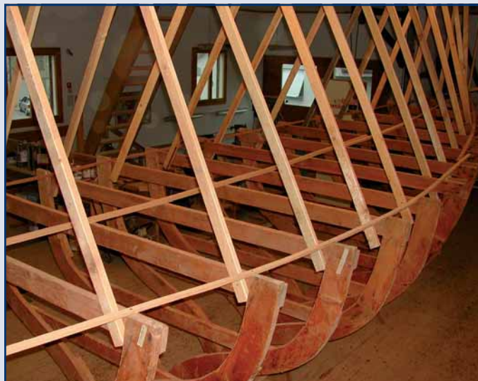
Das Mallengerüst ist aufgerichtet
